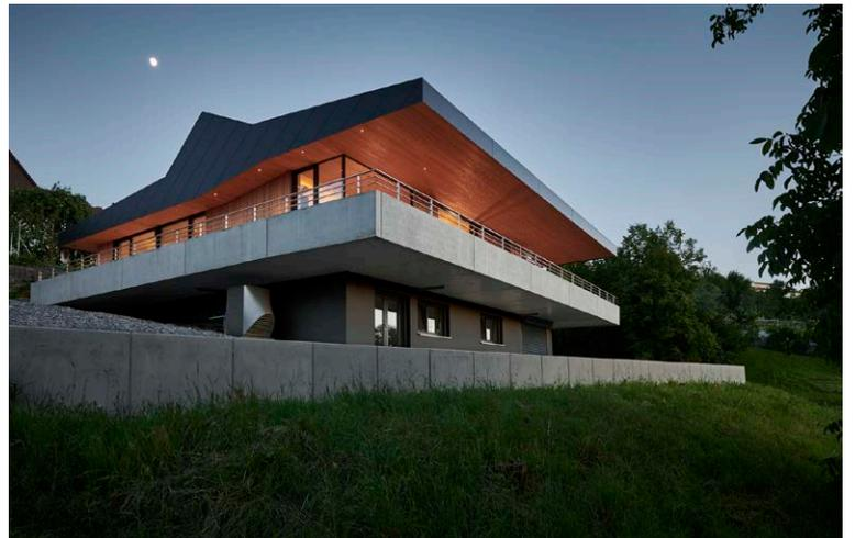
Die Dachkonstruktion ist so ausgebildet, dass nebst statischen und wärmedämmtechnischen Funktionen, auch Funktionen der zenitalen Lichtführung, wie auch die solare Wärme- und Stromgewinnung im „Dachkörper“ untergebracht sind. Die Dachkonstruktion wird somit zur funktionalen Einheit und zum wichtigsten Bauteil dieses Gebäudes. Die Dachkonstruktion besteht vollständig aus Holz und ist analog einer Flugzeugtragfläche als Raumfachwerk konstruiert.
